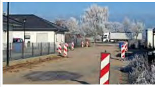
160.000 Euro im Haushalt: Der Endausbau Hinter den Höfen III in Ehra soll in nächster Zeit beginnen. Jörg Rohlfis
